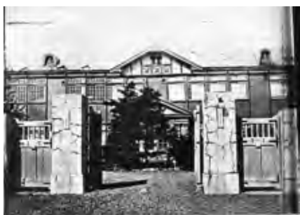
図1 北海道旭川師範学校校舎 大正末期 画像提供：旭川図書館
